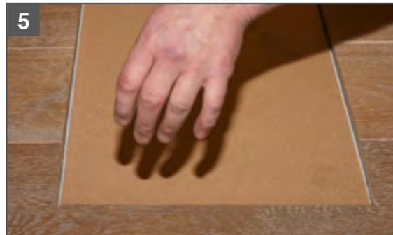
5. Mit beiliegender Unterlage 3 mm oder 5 mm Höhe ausgleichen, oder beide Unterlagen für 8 mm Höhenunterschied kombinieren.
