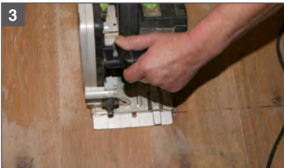
3. Mit Kreissäge angezeichneten Ausschnitt zum Boden einschneiden.
