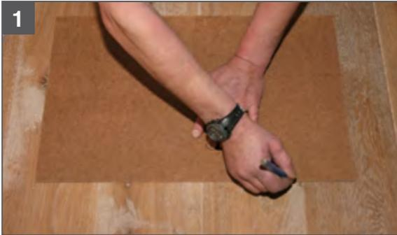
1. Mit beiliegender 3 mm Unterlage Position der Matte anzeichnen.
